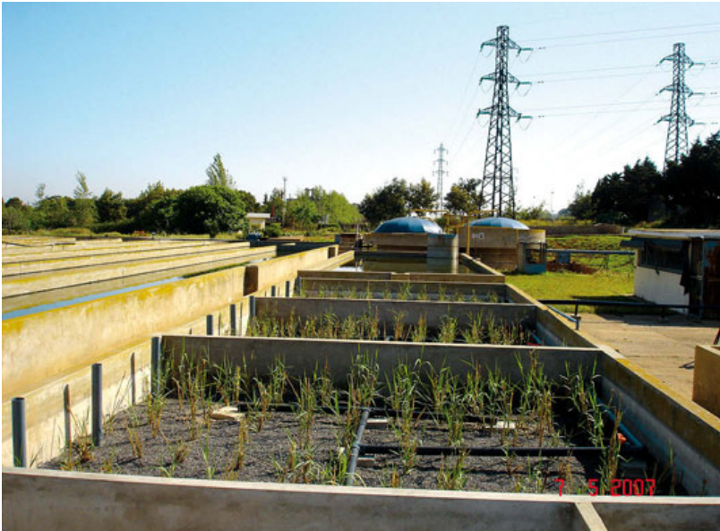
Figure 3: FILTRE PLANTÉ PRÉTRAITEMENT, ÉCOULEMENT VERTICAL
