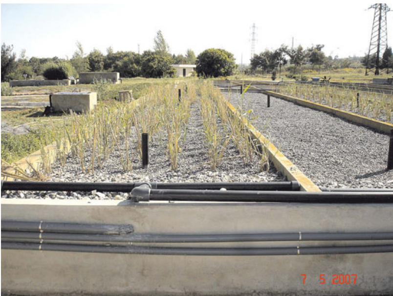
Figure 4: FILTRE PLANTÉ ÉCOULEMENT HORIZONTAL
