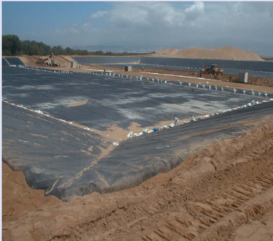
Pose géotextile
