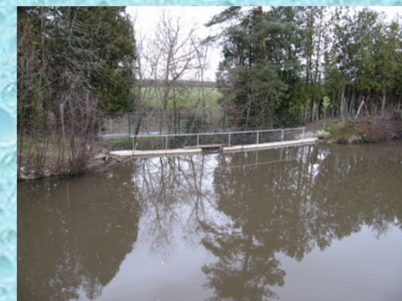
VTA Barrage de l'étang de la Molière France
